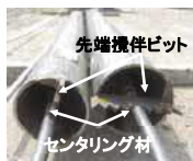
杭先端部の構造
