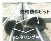
杭先端部の構造
