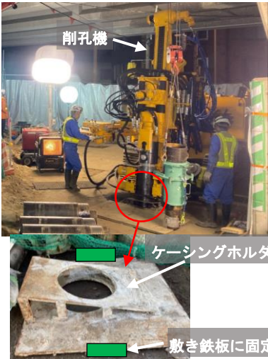
写真-1 ケーシング設置状況
