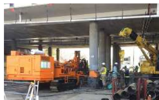
写真-3 補強杭施工状況
