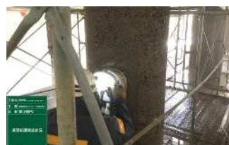
写真-5 表面処理工
