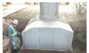
写真-4 底版拡幅完了
