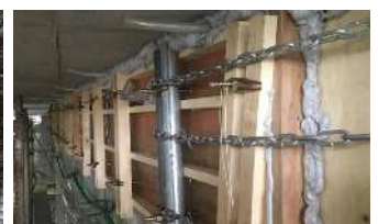
写真-8 モルタル注入工
