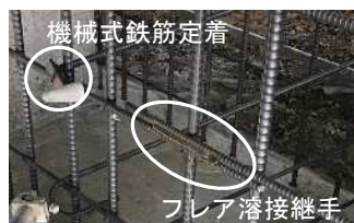
写真-7 帯鉄筋定着・継手
