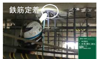
写真-6 軸方向鉄筋定着
