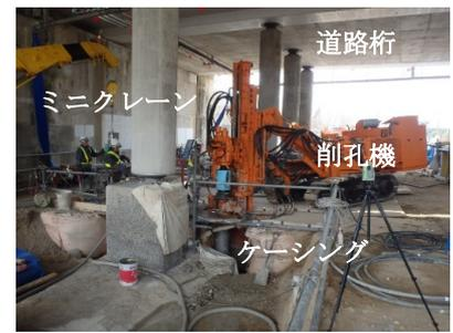
Photo 1 二重管削孔状況
