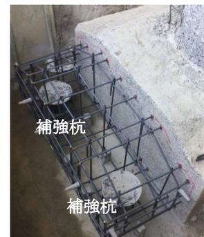
Photo 3 補強杭の施工完了状況
