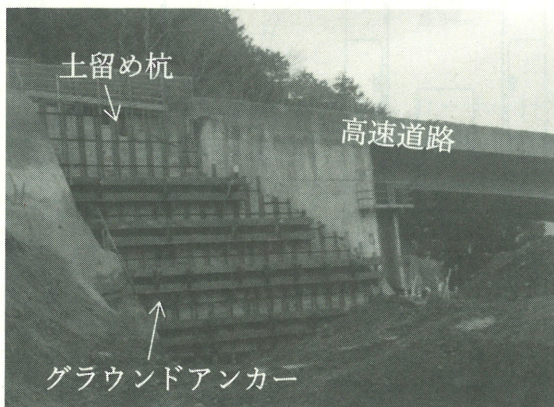
写真8 高速道路に近接した親杭横矢板形式
