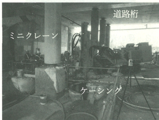
写真2 道路橋基礎における増し杭の削孔状況
