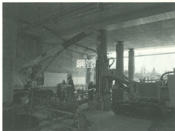
写真3 \phi 267.4\text{mm} 鋼管の建込み状況
