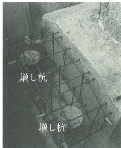
写真4 増し杭の施工完了状況
