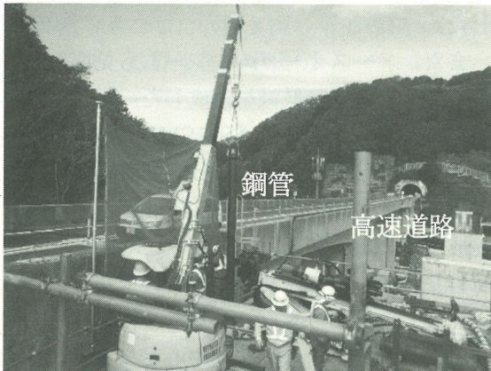
写真7 斜面足場上での鋼管建込み状況
