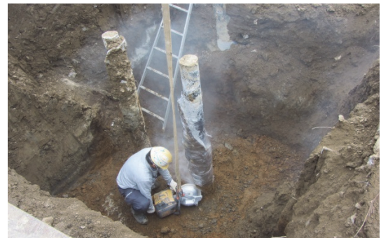
写真-6 試験杭の試掘調査
