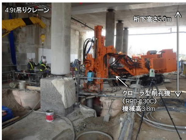
写真5 道路橋基礎の補強杭に適用した事例
