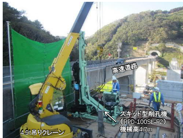
写真6 高速道路に近接する土留め親杭に適用した事例
